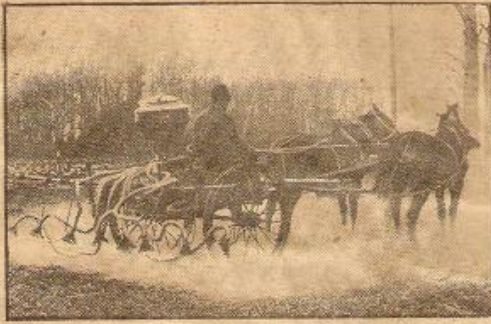
Opylacz motorowy do opylania buraków proszkami trującymi w celu ochrony przed szkodnikami.
